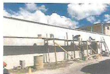
Foto 6: Repello y cernido de pared total parte exterior
