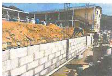
Foto 3: Colocación de block y solera intermedia
