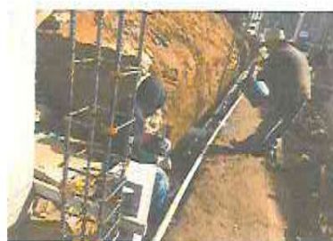
Foto 2: Cimiento de humedad
