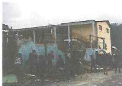
Foto 1: Demolición de pared existente
