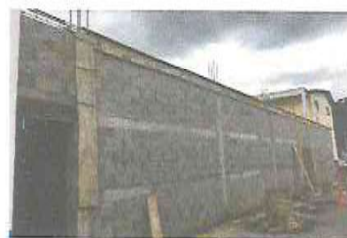
Foto 4: fundición de solera final o corona
