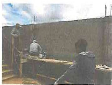
Foto 5: Repello y cernido de pared total parte interna del muro
